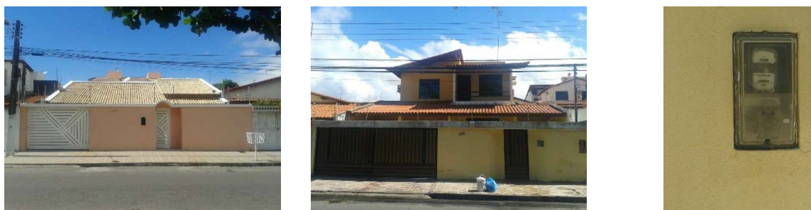
Figura 5. Caracterização das fachadas das construções típicas localizadas nos limites da Praça Guadalupe Amado Mendonça e detalhe do medidor de energia único no lote.
